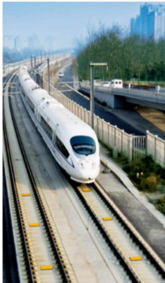
Für High-Speed-Züge ist Leittechnik ein Muss.
