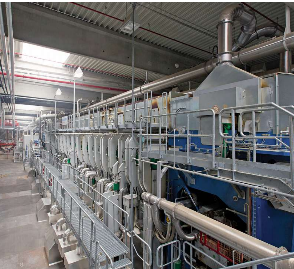
Bild 1: Eine effektive Steuerung regelt die gegenwärtig größte und modernste Spanplattenproduktion in Europa.
